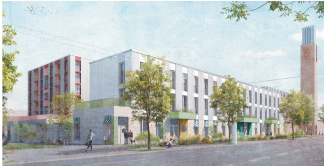
Der Neubau neben dem Kirchenzentrum Glaubten bietet mehreren Einrichtungen Platz: Fachspital Sune-Egge, Pflegeheim Sunegarte, Wohnsiedlung Brothuse und Administration.
