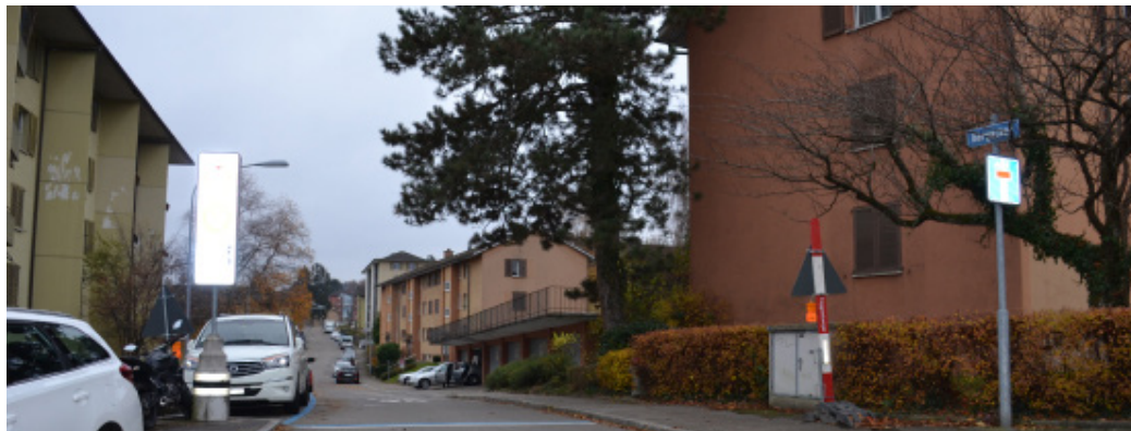
Der Abriss der 1. Etappe der Siedlung Bergacker wird frühestens 2026 sein.
